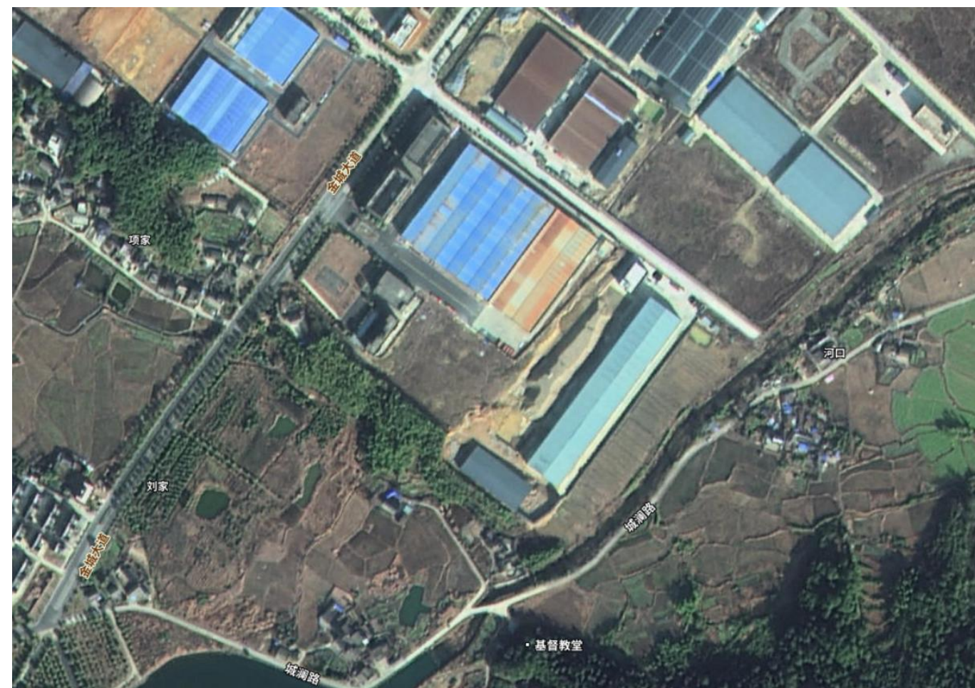
图 3.5-2 黄山明荣建筑垃圾回收利用制砂项目厂
