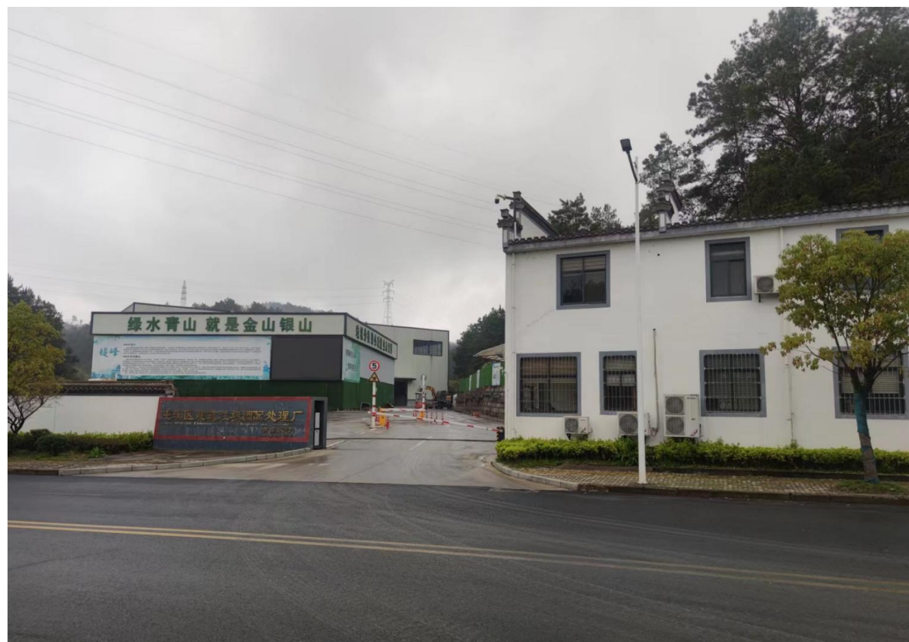
图 3.5-1 屯溪区建筑垃圾调配（处理）厂
