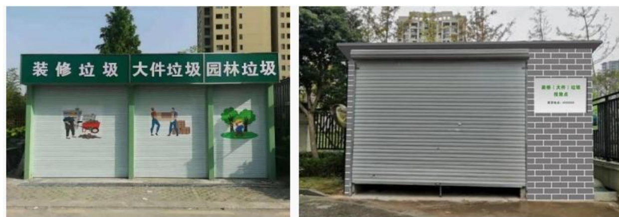
图 7.4-2 住宅小区装修垃圾集中投放点示例
